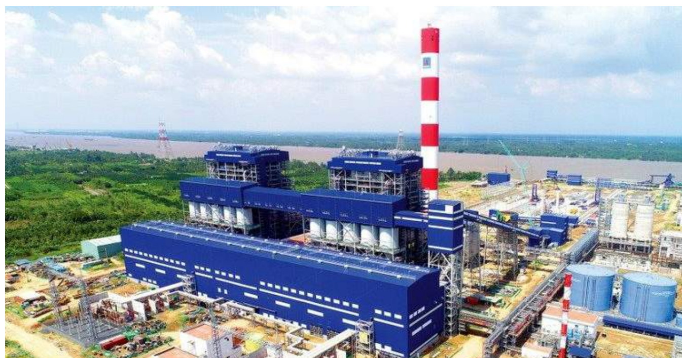
Dự án Nhơn Trạch 3,4 Nhon Trach 3, 4 project
